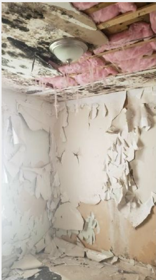
i. isolant et finition délabrés
