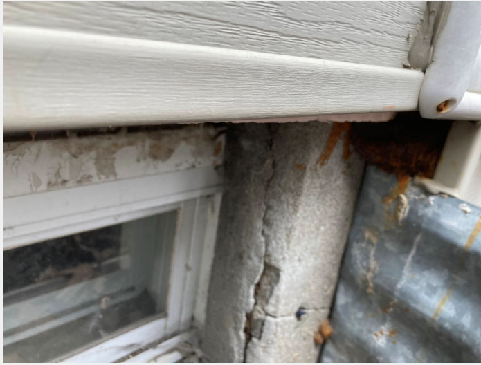
Dégradation des murs de fondation - à reconstruire
