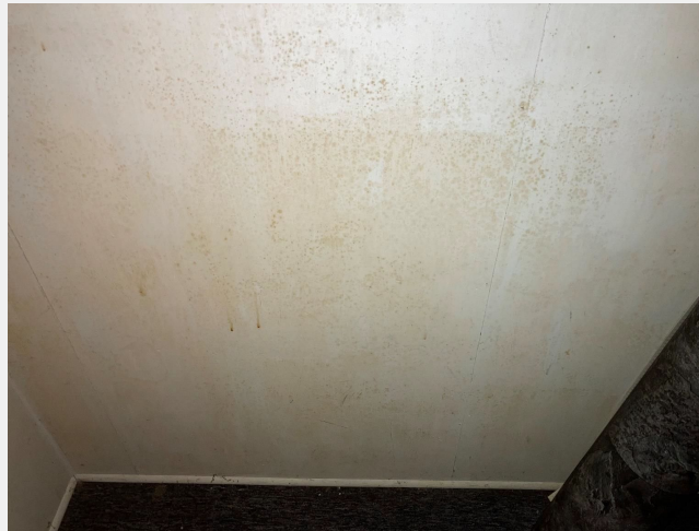
Moisissures au sous-sol - présence d'humidité
