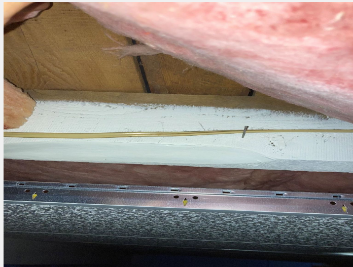
Solives de dimensions inadéquates - charge supplémentaire en raison du soufflage du plancher
