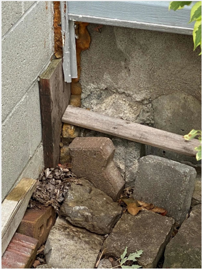
Dégradation des murs de fondation - à reconstruire
