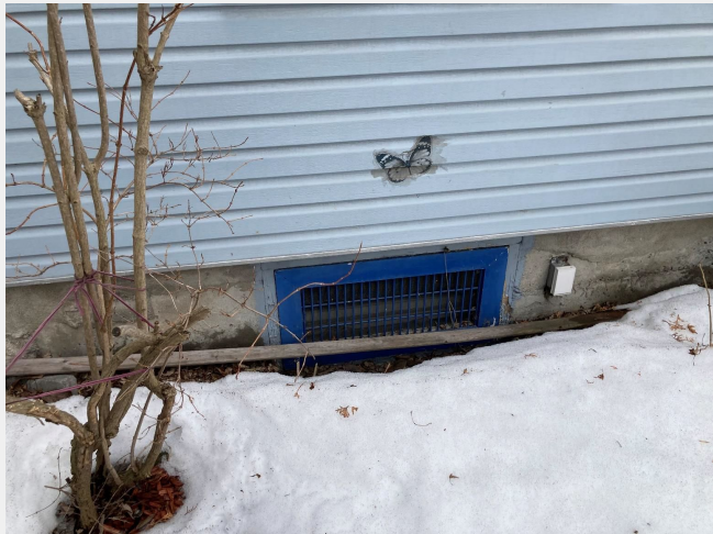
Absence de margelles et d'imperméabilisation
