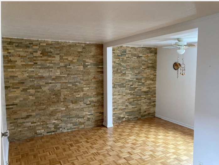
Hauteur plancher-plafond non conforme (7')
