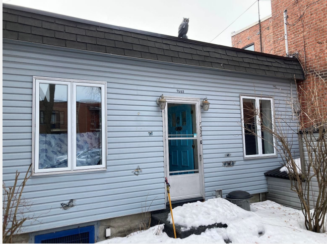
Revêtements désuets à remplacer - risque d'infiltrations d'eau
