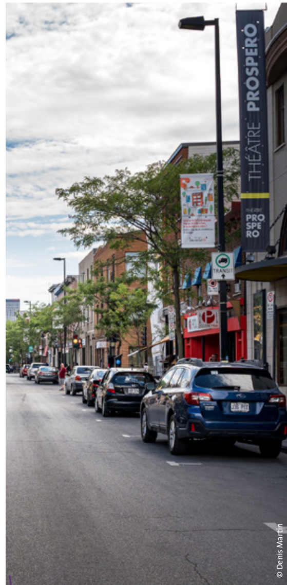
Rue Ontario Est
