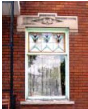
Fenêtre à guillotine \frac{1}{3} - \frac{2}{3} et vitraux
