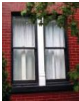
Fenêtre à guillotine \frac{1}{2} - \frac{1}{2} double Pied-droit en bois au centre
