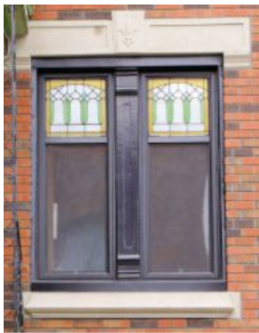
Fenêtre à guillotine \frac{1}{3} - \frac{2}{3} double avec battants intérieurs ou à crémone (2 vantaux)
