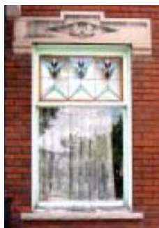
Fenêtre à guillotine \frac{1}{3} - \frac{2}{3} et vitraux
