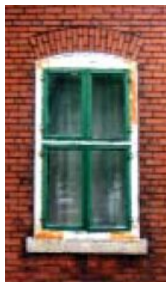
Fenêtre \frac{1}{2} - \frac{1}{2} à battant 2 vantaux ou à crémone 2 vantaux
