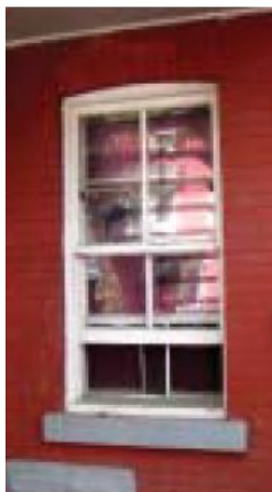
Fenêtre à guillotine \frac{1}{2} - \frac{1}{2} avec croisillon
