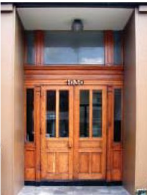
Porte double avec impostes latéraux Panneaux décoratifs en RELIEF Vitrage FIXE Impostes en plusieurs sections
