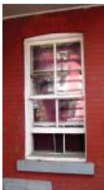
Fenêtre à guillotine \frac{1}{2} - \frac{1}{2} avec croisillon
