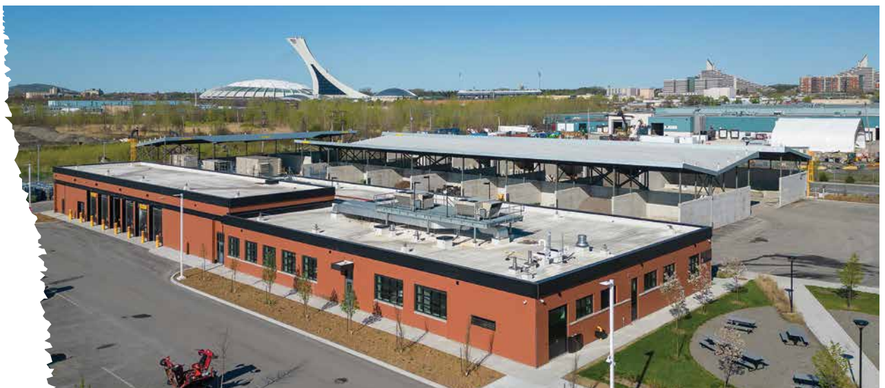
Cour de voirie de MHM
