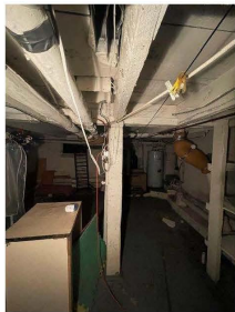
Photo 3 : Le sous-sol du bâtiment est divisé en 3 sections, soit le sous-sol du bâtiment d'origine avec dalle sur sol, un vide sanitaire du côté nord du bâtiment et un vide sanitaire arrière. La charpente du plancher du rez-de-chaussée du bâtiment d'origine est composée de solives (2x10 @ ±30" C/C) perpendiculaires à la rue venant se fixer sur une poutre au centre du bâtiment. La poutre est appuyée sur les fondations et sur une colonne de bois au centre de sa portée.
