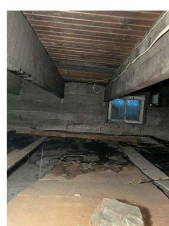
Photo 10 : Le vide sanitaire de l'agrandissement nord-est est divisé en deux sections séparées par un mur de fondation. La section arrière est partiellement remblayée. Les solives portent parallèlement à la rue d'une part sur un nouveau mur de fondation en béton et de l'autre sur le mur de fondation d'origine (voir photo 5). Les murs de fondation de l'agrandissement semblent être en bonnes conditions.
