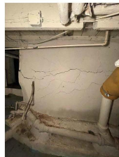
Photo 6 : Le mur de fondation séparant le sous-sol du vide sanitaire de l'agrandissement nord-est est dans un état précaire. On observe un flambement important du mur qui cause la fissuration de celui-ci. Au coin du sous-sol, une ouverture donne accès au vide sanitaire.
