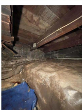
Photo 7 : Une déformation du mur de fondation avant est également présente.
