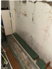
Photo 6 : Le mur de fondation séparant le sous-sol du vide sanitaire de l'agrandissement nord-est est dans un état précaire. On observe un flambement important du mur qui cause la fissuration de celui-ci. Au coin du sous-sol, une ouverture donne accès au vide sanitaire.
