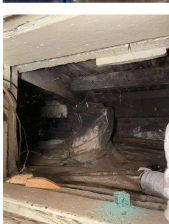
Photo 8 : Autre exemple de déformation importante d'un des murs de fondation du bâtiment d'origine.
