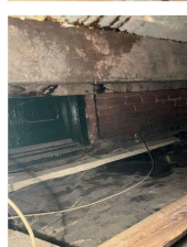
Photo 11 : La section avant du vide sanitaire est quant à elle entièrement remblayée. Une ouverture dans le mur de fondation d'origine permet d'y avoir accès. Cette section est différente de l'arrière. Des murs de maçonnerie sont apparents contrairement aux murs de béton pour l'autre section. Cela nous amène l'hypothèse que la section avant du vide sanitaire est un agrandissement plus vieux qu'à l'arrière. Le plancher en planche repose sur une série de poutres et solives toutes de dimensions différentes.
