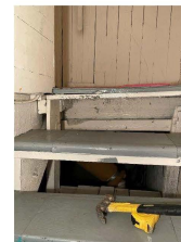
Photo 12 : Toujours dans la section avant du vide sanitaire, on remarque qu'une solive porte dans le vide à l'une de ces extrémités.
