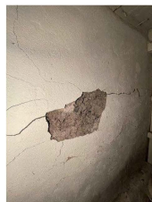
Photo 7 : Une déformation du mur de fondation avant est également présente.
