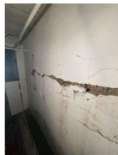
Photo 8 : Autre exemple de déformation importante d'un des murs de fondation du bâtiment d'origine.
