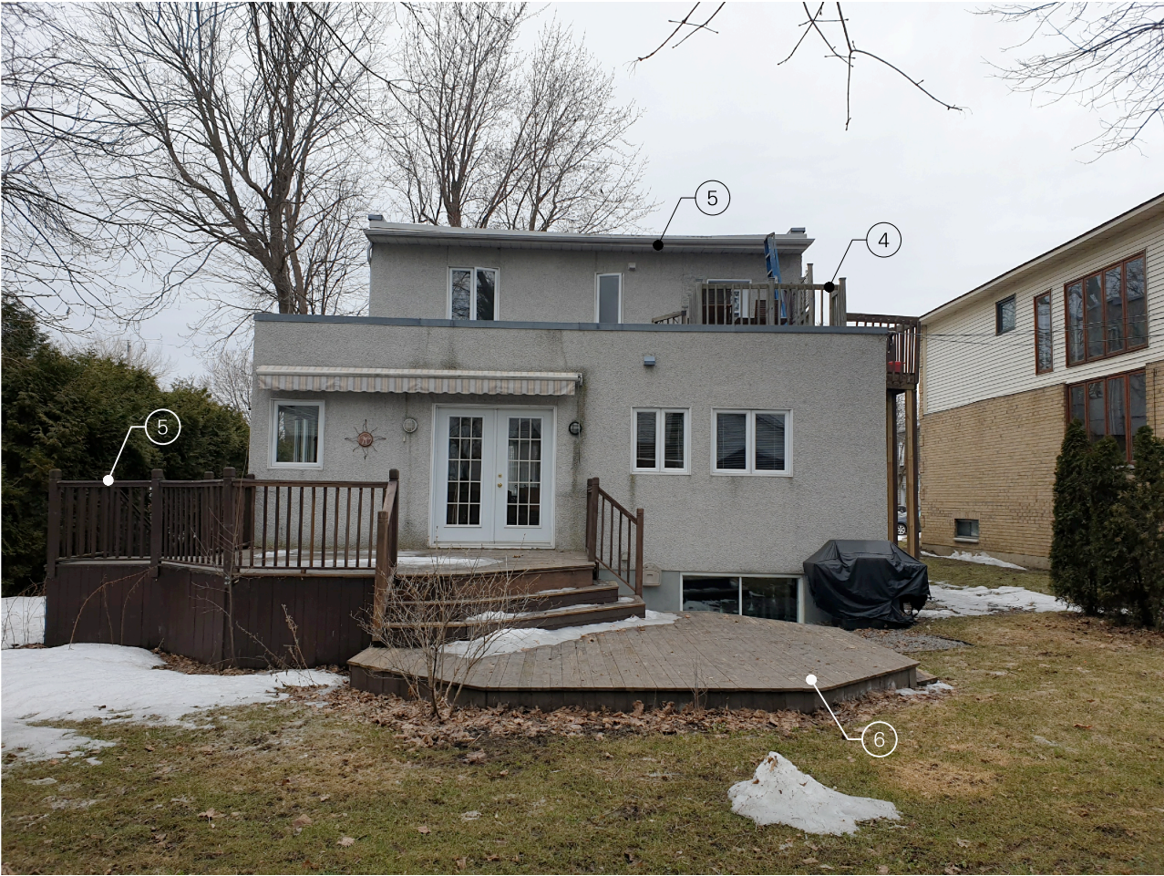
PHOTOS EXISTANT - FAÇADE ARRIÈRE
