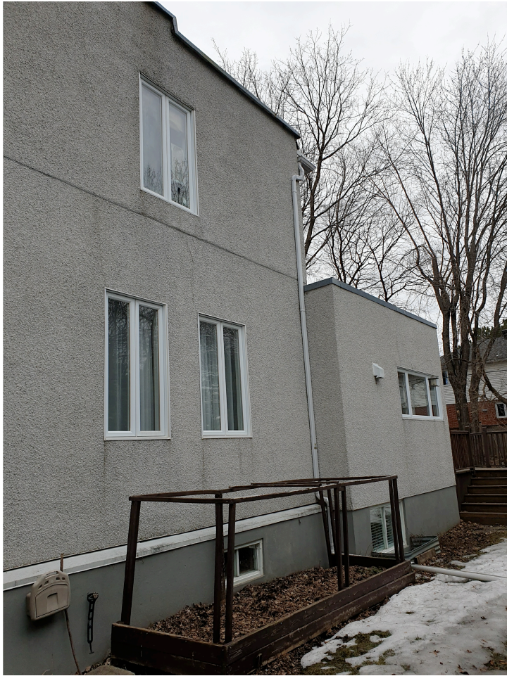
PHOTOS EXISTANT - FAÇADE LATRALE DROITE
