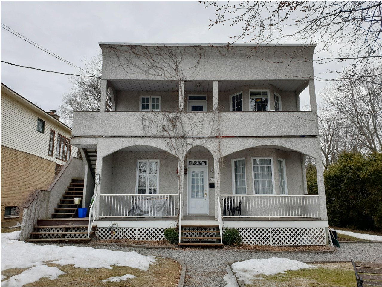
PHOTOS EXISTANT - FAÇADE AVANT * AUCUNE INTERVENTION
