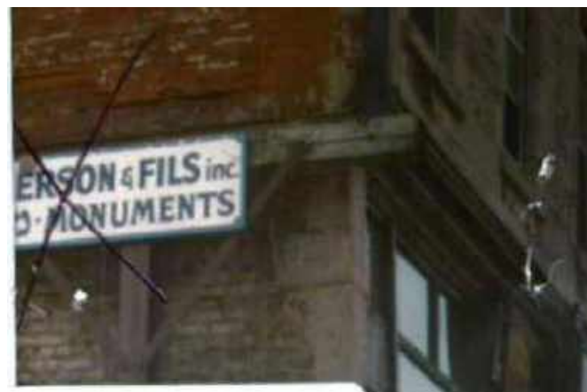
L'enseigne à plat située sur le mur nord, présents à la fin des années 1976. Carton d'enseigne, Ville de Montréal, dans les années 1980.
