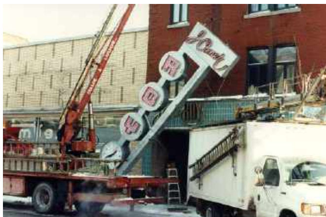
Installation de l'enseigne A à la suite de son reconditionnement, en 1993. SDC Mont-Royal, 1993.
