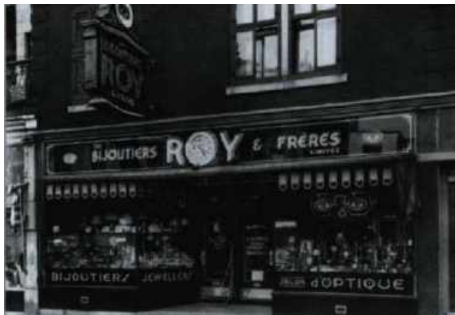
Les enseignes de l'ancienne façade de Bijoutiers Roy & Frères Limitée, avec une enseigne à plat en en métal réfléchissant ( glassweld ) peint avec une horloge au centre et une enseigne en saillie en tôle avec métal peint à la main et néon exposé dans les années 1940. Collection personnelle d'André Roy.
