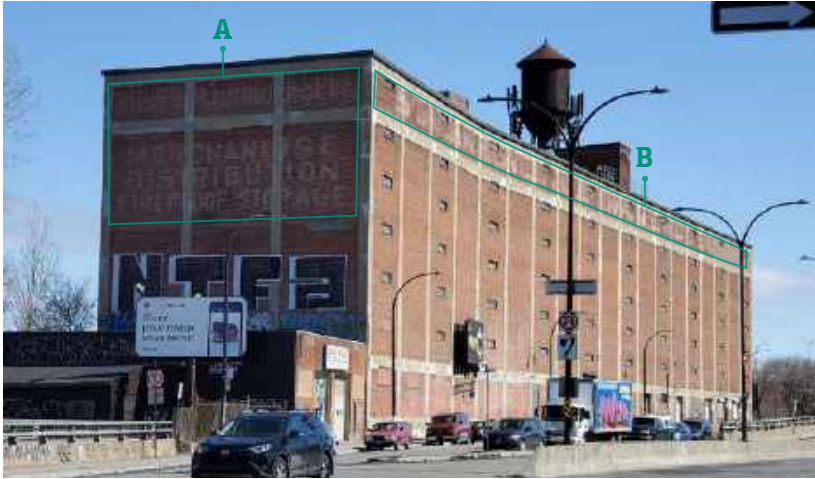
Les enseignes A et B de la Van Horne Warehouse depuis la rue Saint-Urbain, 2020.
