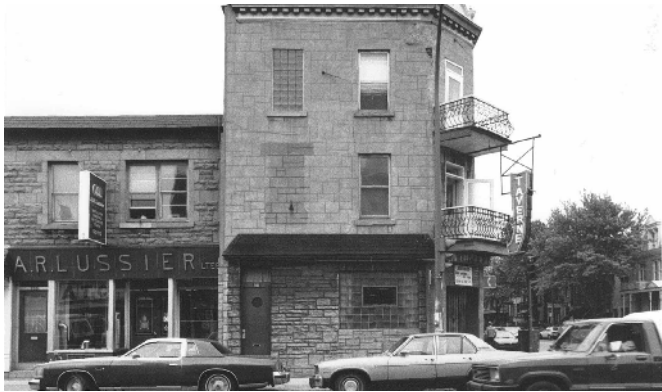
L'enseigne A, au tournant des années 1980. On remarque que l'enseigne B n'est pas encore installée. Communauté urbaine de Montréal (CUM), 1975-1982.
