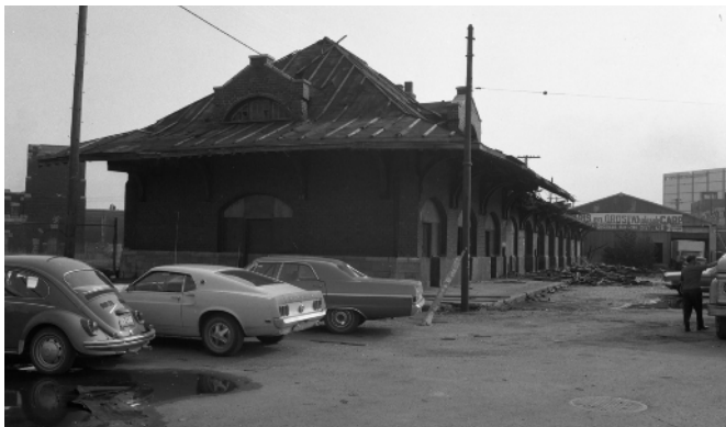
La gare du Mile-End lors de sa démolition, en 1970. On remarque que le 77, rue Bernard Est est déjà présent. Archives de la Ville de Montréal, VM94-C1482-001.
