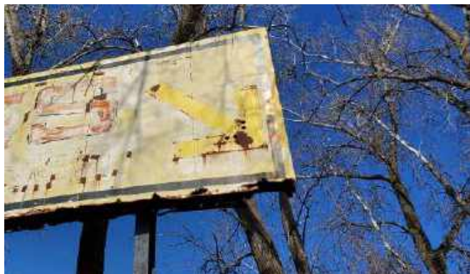
Détail au dos de l'enseigne, qui ressemble à des trappes d'accès pour des transformateurs à tubes néon, 2020.
