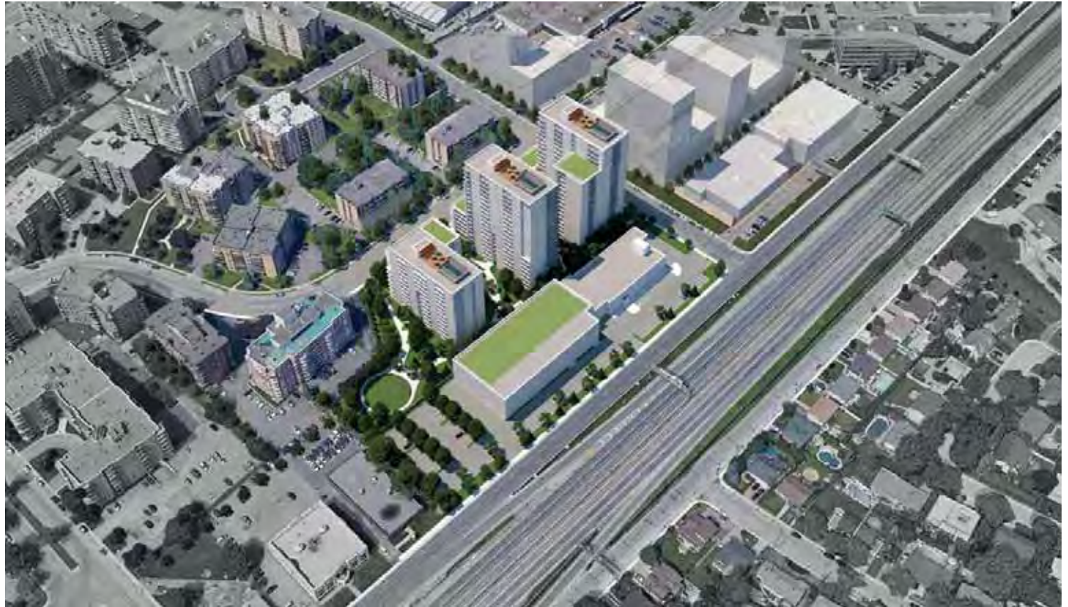
Fond de plan : Google Earth / Volumétrie : BC2 | Volumes sur le site adjacent à titre indicatif
