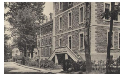
583. Vue de l'escalier avant son remplacement, entre 1903 et 1920
