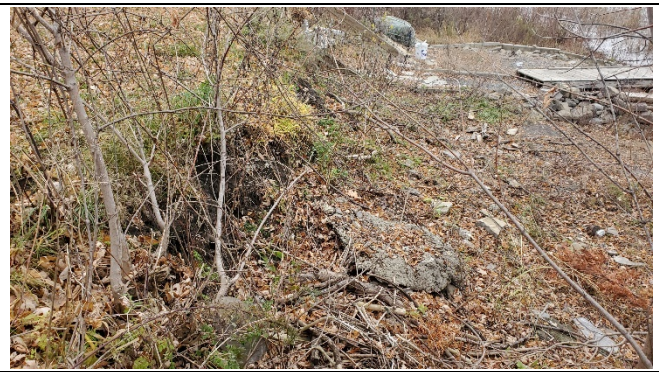
Photo 4. Petit talus en érosion, secteur sud (0+350).
