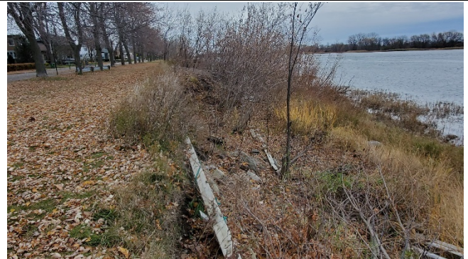
Photo 6. Présence de déchets sur la berge (0+240).
