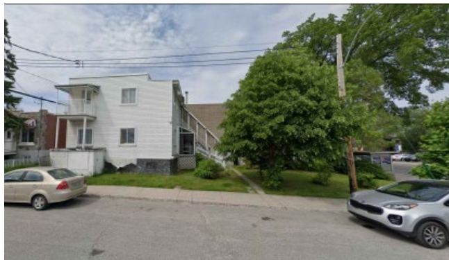
Bâtiment à démolir - Rue Billaudeau
