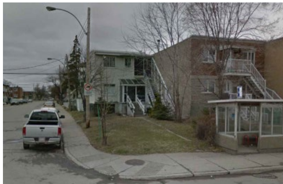
Bâtiment à démolir - Rue Notre-Dame Est
