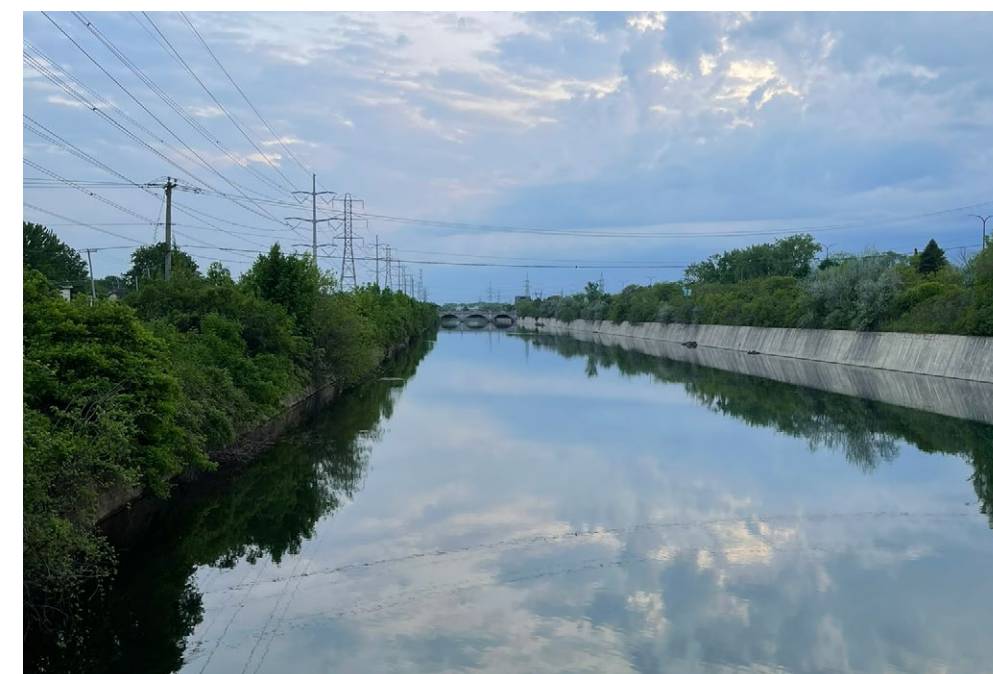
Fig. 23 Canal de l'Aqueduc
