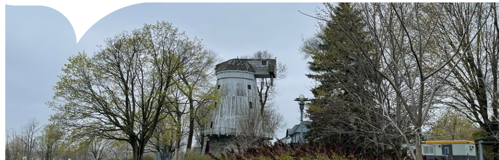
Fig. 7 Moulin Fleming du parc Stinson
