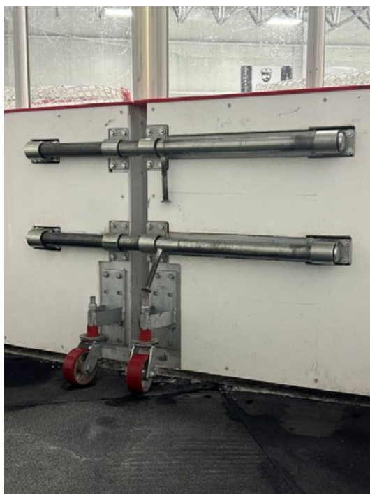
Figure 10.3.1.18 – Barre de verrouillage et œillet portrait
