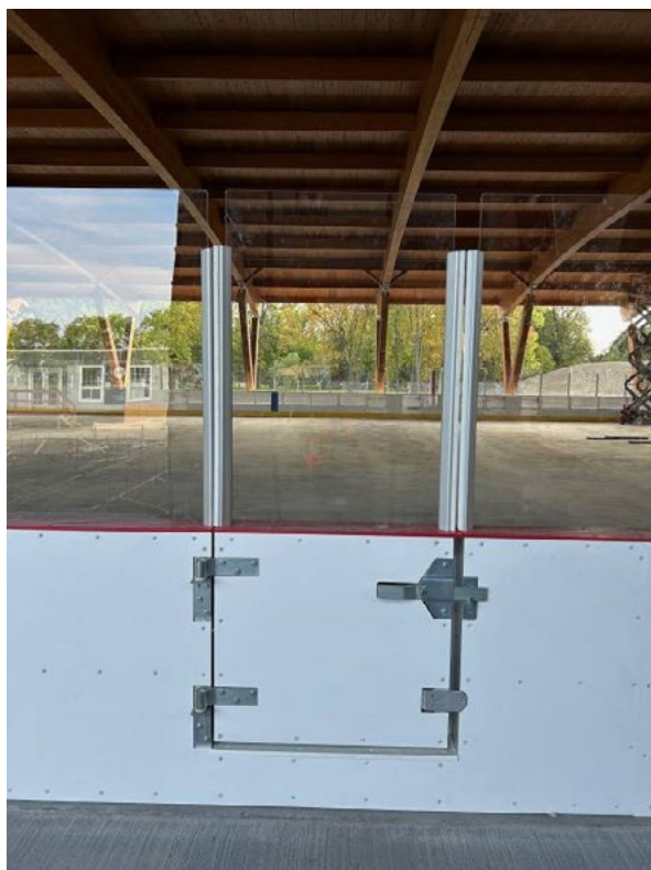
Figure 10.3.1.24 – Demi-support à baie vitrée pour porte
