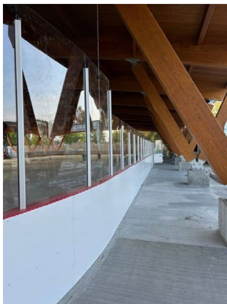
Figure 10.3.1.26 – Support à baie vitrée, vue générale
